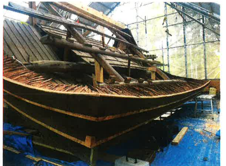
▲軒付積、施工完了（他建物）
