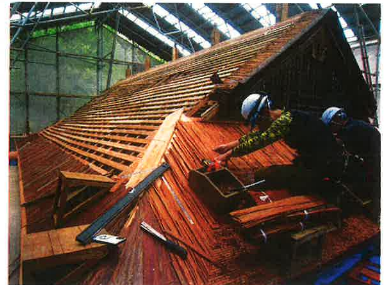
▲平葺き、作業状況（他建物）
