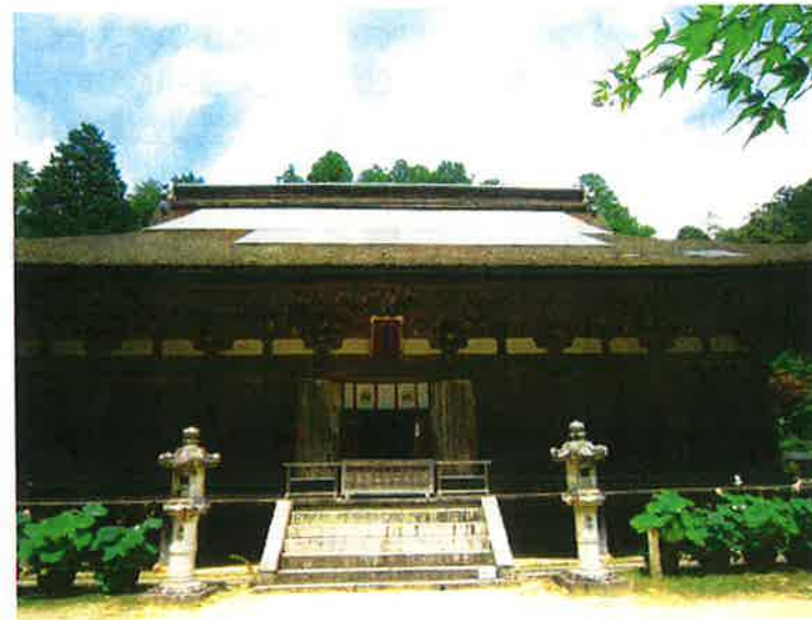
▲修理前の状況
