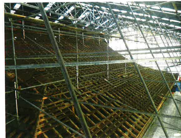
▲檜皮解体後の状況
